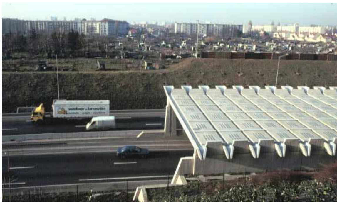
Couverture sur A86 à Thiais
