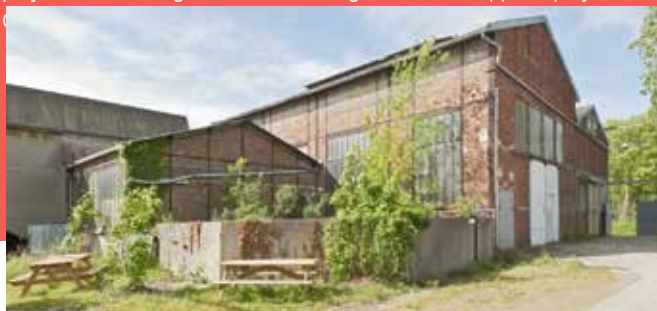
Reconversion de l'usine EIF à Montrouil (93)
