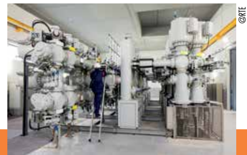
Poste électrique sous enveloppe métallique
