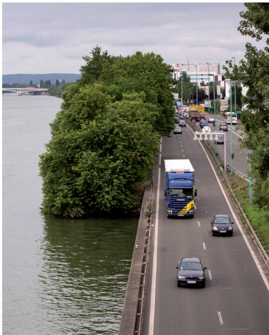
© Droits réservés La Départementale 311, élargie au détriment de la Seine
