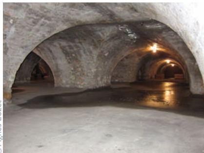
Galerie voûtée de 2 000 m 2
