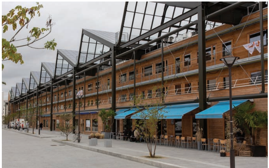
Centrale photovoltaïque Halle Pajol, après aménagement
