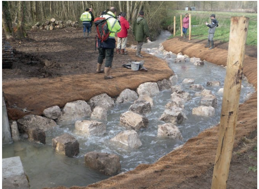
Mise en eau de la passe à poissons de Flagy-sur-l'Orvanne en Seine-et-Marne
